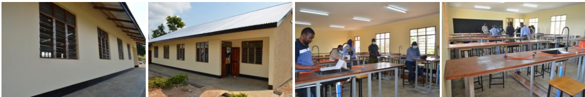
Mwonekano wa nje na ndani wa jengo la maabara ya sayansi la Shule ya Sekondari Bujunangoma Kata Kemondo
