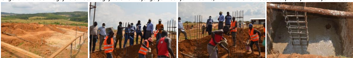
Ujenzi wa Ofisi za Makao Makuu ya Halmashauri ya Wilaya Bukoba Bujunangoma Kata Kemondo
