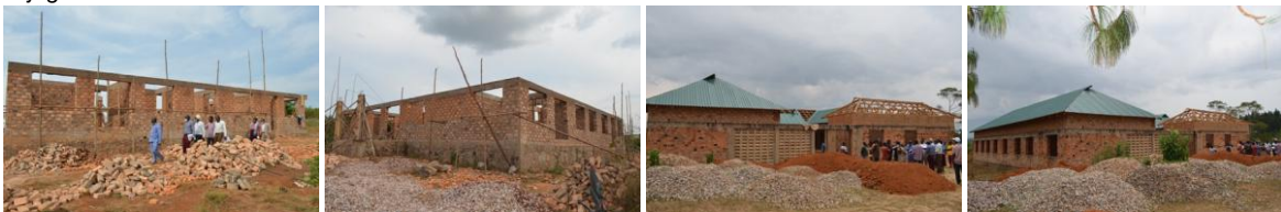
Jengo la Zahanati ya Bituntu Kata Rukoma
